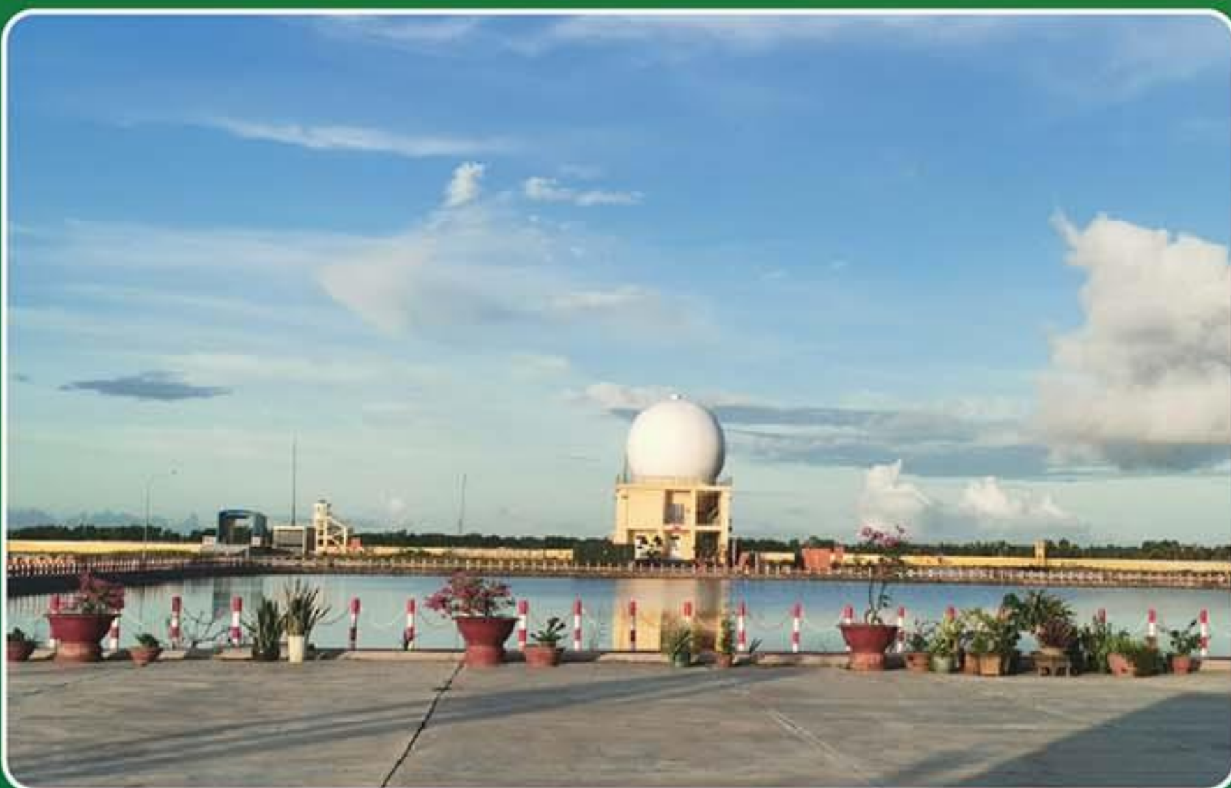
TRẠM RADAR CÀ MAU
