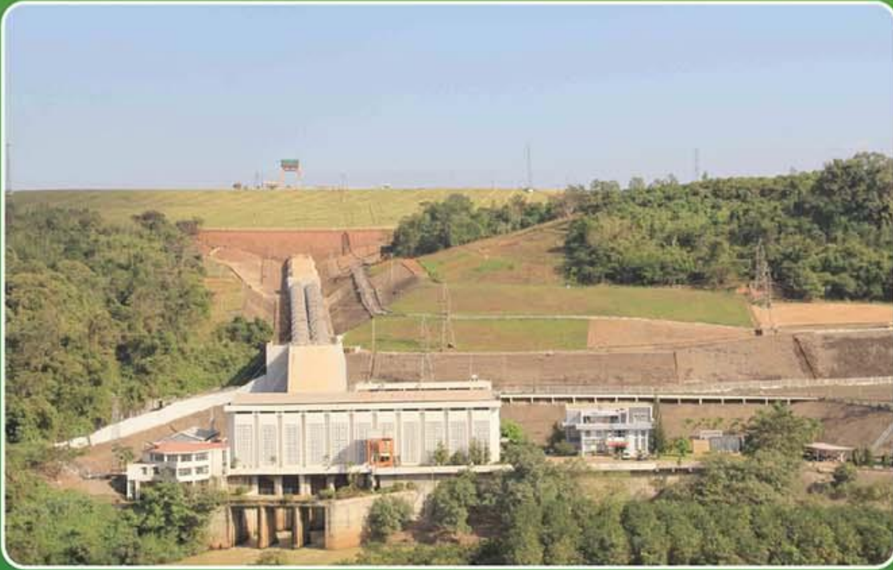
NHÀ MÁY THỦY ĐIỆN THÁC MƠ
